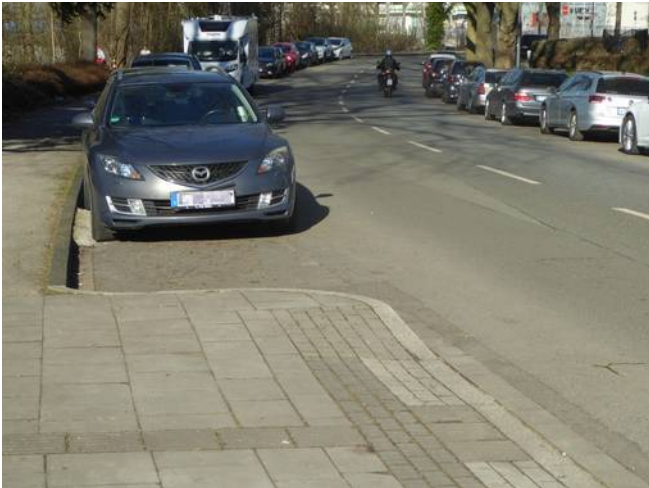
Bild 64: Gehwegvorstreckungen verdeutlichen die Lage der Fahrgasse.
