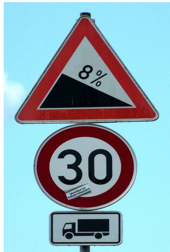
Bild 15: Tempo 30 an einer Gefahrenstelle, nämlich einem starken Gefälle, hier beschränkt auf Fahrzeuge über 3,5 t zulässigem Gesamtgewicht.
